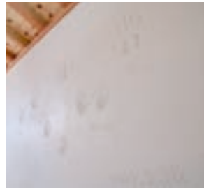
小屋裏の壁には建築途中に家族で付けた記念の手形が残されている。
