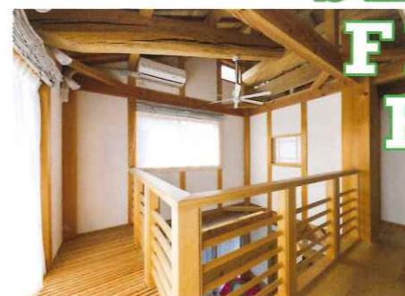
2階ホールはリビングからロフトへ続く吹き抜けの緩衝エリアで、スノコ状のキャットウォークからも階段へ光を送る。普段は室内干しスペースとして利用
