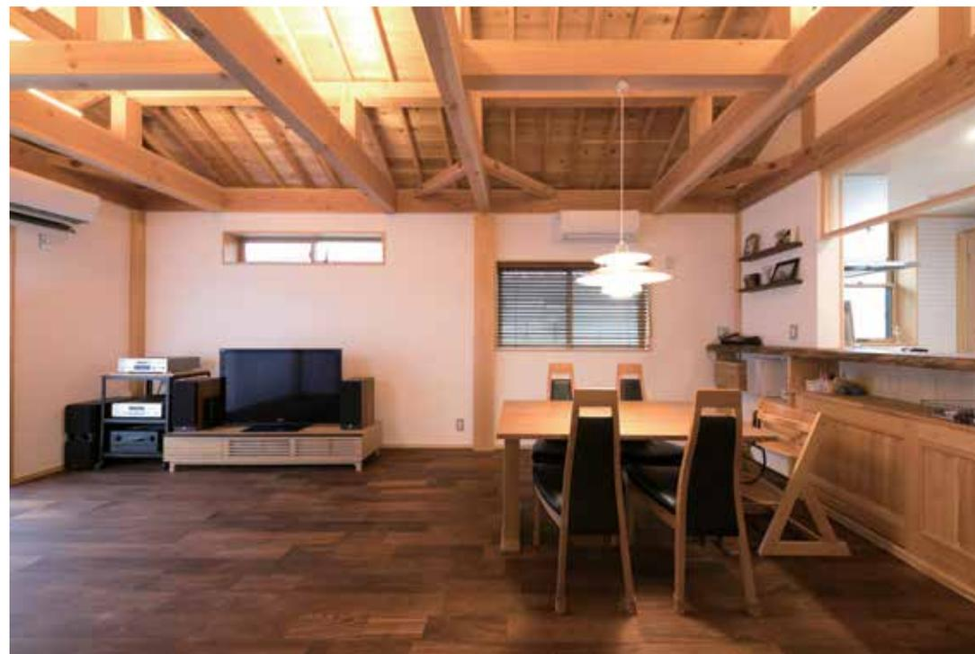
2階リビング床はウォールナット、壁は珊瑚漆喰で大壁ですが通し柱が太いので見えています。もちろん天井は高断熱の5層構造。
