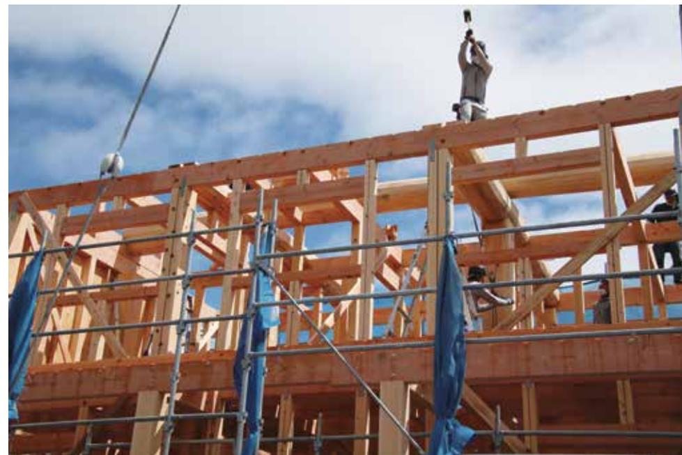
上段は1階部分を組み上げた状態で、通し柱の太さが際立ちます。下段は梁を組み込んでいるところ。
