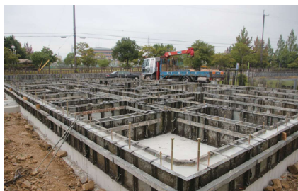
基礎となるコンクリートの厚さや立ち上がりの多さが強度を物語る。見えないところこそ責任を持って施工するのが同社の信条
