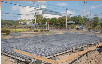
一般住宅とは思えないほどの太さと量の鉄筋を使用。平屋建てでも3階建てに相当する高強度のベタ基礎を標準仕様に
