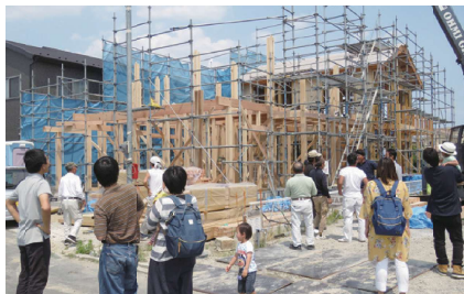
棟上げには毎回多くの見学者が訪れ、ひと目で構造の強さを実感できる。棟上げの様子は同社HPにて動画で公開
