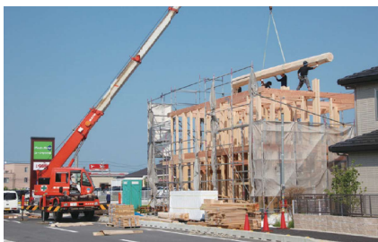
棟上げの様子。遠目でも見て木材の太さ、構造の強さは一目瞭然。「2階のどこでもランドピアノが置けますよ」(喜代次さん)
