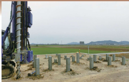
軟弱な地盤にはPCパイルによる地盤補強を実施。全ての杭(くい)が支持層まで達していることを施主と確認する
