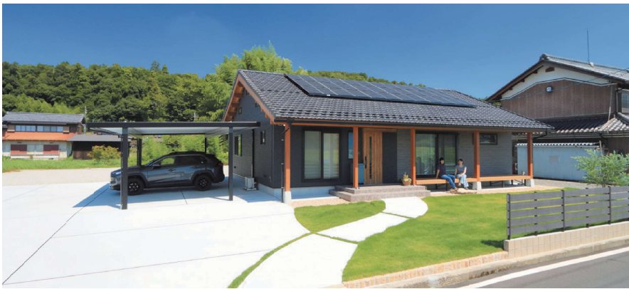
グレーを基調にした和モダンな切妻屋根の平屋。周囲の環境に馴染みながらも存在感抜群。南向きの屋根にはソーラーパネルを設置
