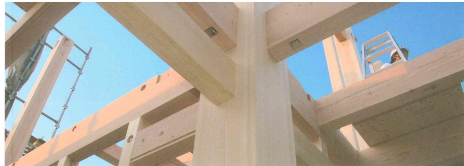
1本1本が圧倒的な強さを持つ自然乾燥のヒノキ柱や梁(はり)をしっかりと組み上げる
