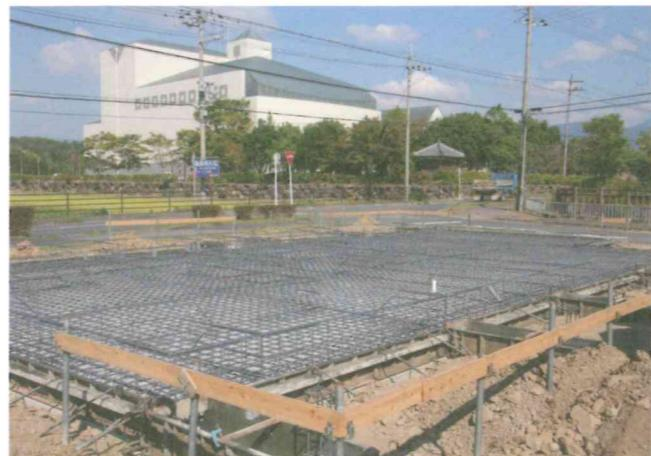
一般住宅とは思えないほどの太さと量の鉄筋を使用。3階建て基準のベタ基礎を標準仕様に
