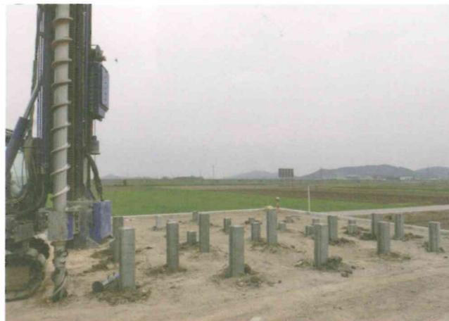
軟弱な地盤にはPCパイルによる地盤補強を実施。全ての杭(くい)を支持層まで到達していることを施主と確認
