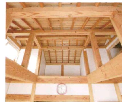
2階の各部屋の上部には通気の窓を設置。空気の流れを考えた設計は同社の特徴
