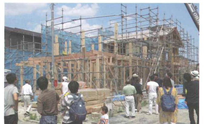
毎回多くの見学者が訪れる棟上げ
