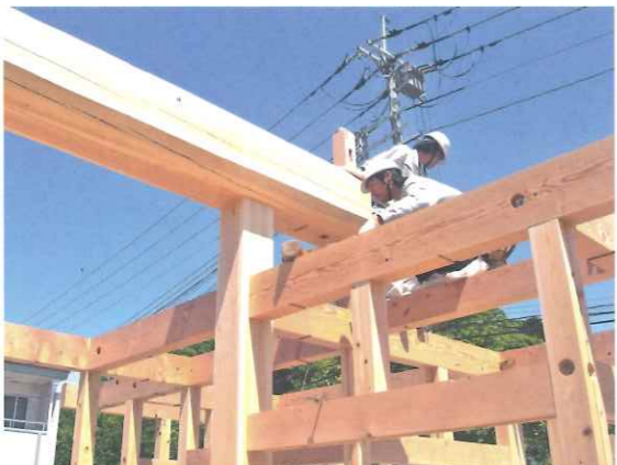
太い柱と梁を組み込んでいきます
