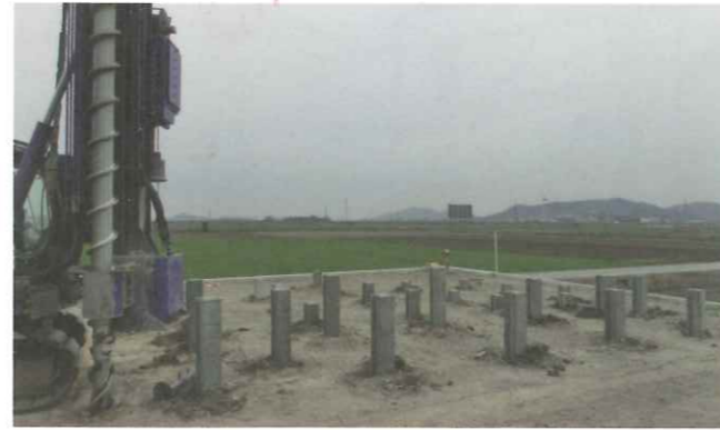
軟弱な地盤にはPCパイルによる地盤補強を実施。全ての杭(くい)を支持層まで到達していることを施主と確認
