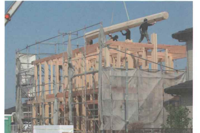
遠目に見ても木材の太さは一目瞭然。現場を見て依頼する人も
