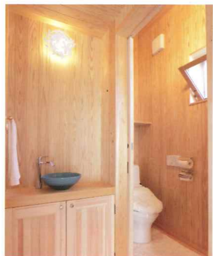
玄関で手洗いができるよう洗面ボウルを設置。トイレの壁は節のないスギ板張り
