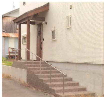
土地が低いため、50cm地盤を上げてから基礎を打つなど災害への配慮も
