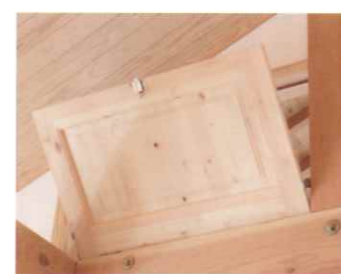
上部にたまった熱を抜く通気窓が随所に設置されている
