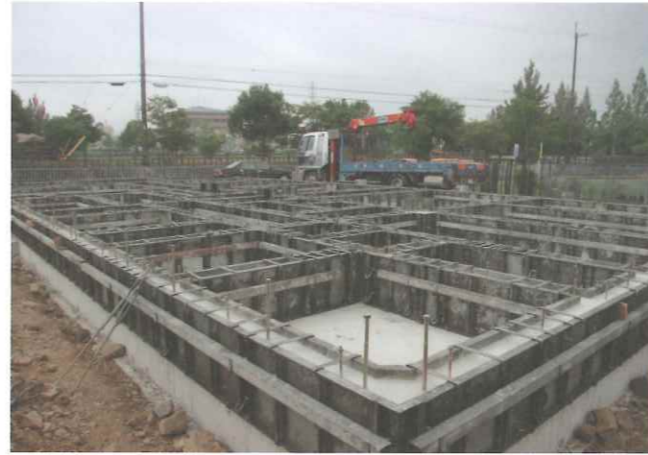
基礎となるコンクリートの厚さが強度を物語る。立ち上がりの部分の多さにも驚き
