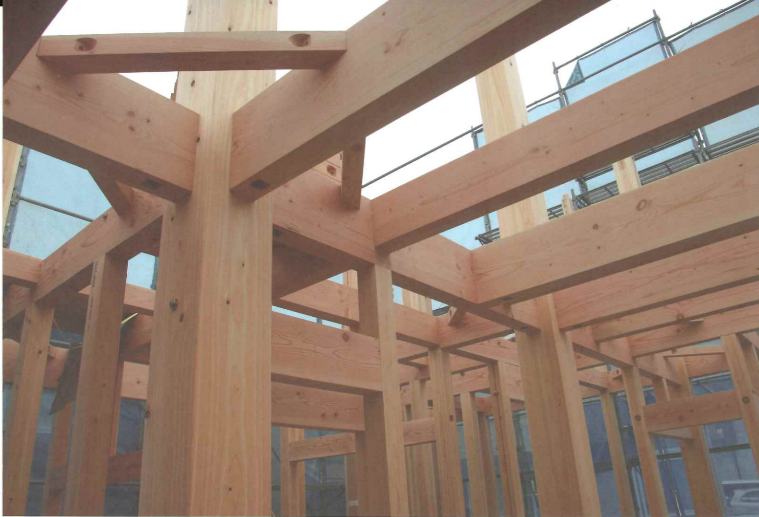
1本1本が圧倒的な強さを持つ自然乾燥のヒノキ柱や梁(はり)をしっかりと組み上げる
