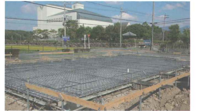
一般住宅とは思えないほどの太さと量の鉄筋を使用。3階建て基準のベタ基礎を標準仕様
