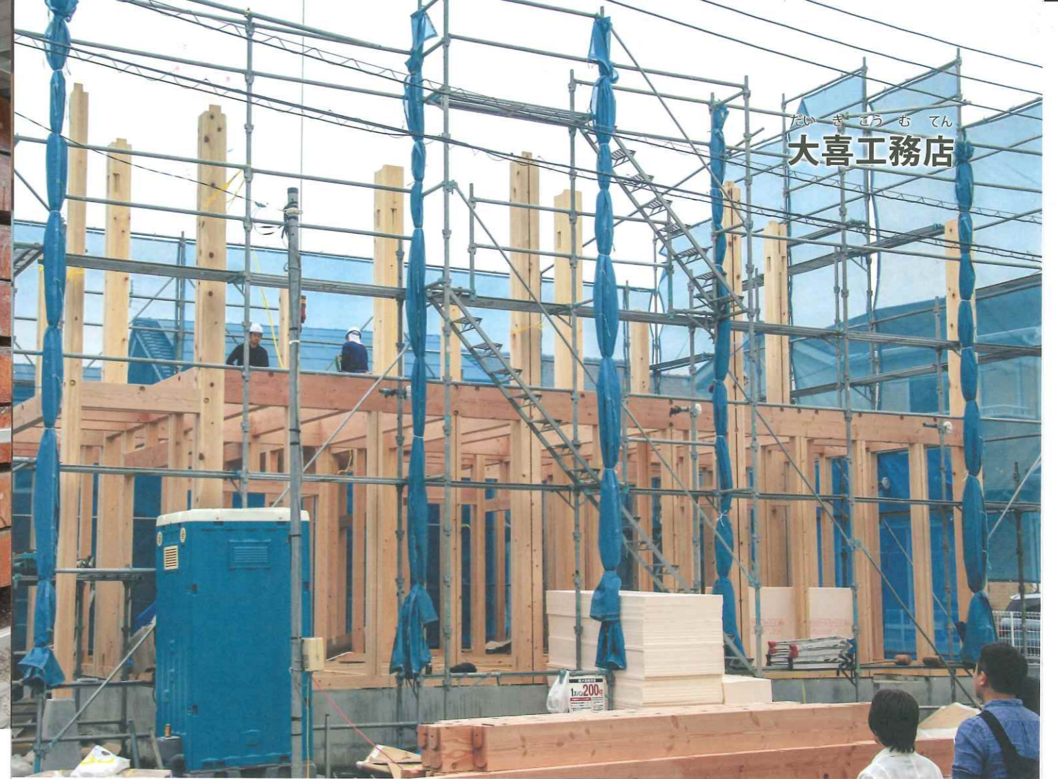
通し柱12本のうち8寸(約24cm)を10本、1尺(約30cm)2本使用。関東地方や東海地方などの遠方からの依頼も増えているそう
