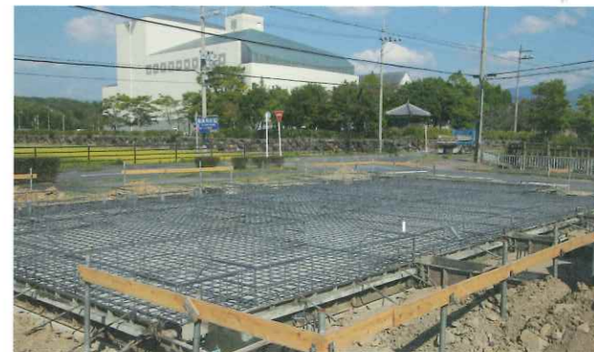
一般住宅とは思えないほどの太さと量の鉄筋を使用。たとえ平屋建てでも3階建て基準のベタ基礎を標準仕様に
