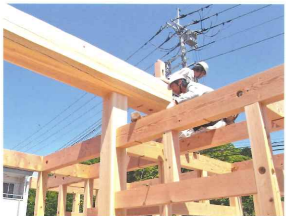
太い柱と梁を組み込んでいきます
