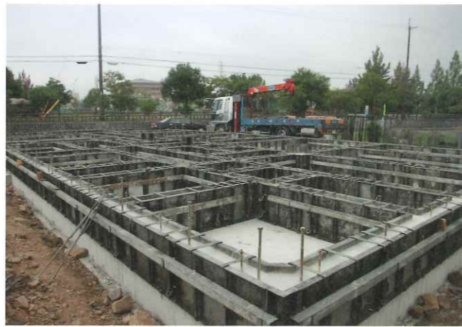
基礎となるコンクリートの厚さや立ち上がり部分の多さが強度を物語る。見えないところにも責任を持って施工
