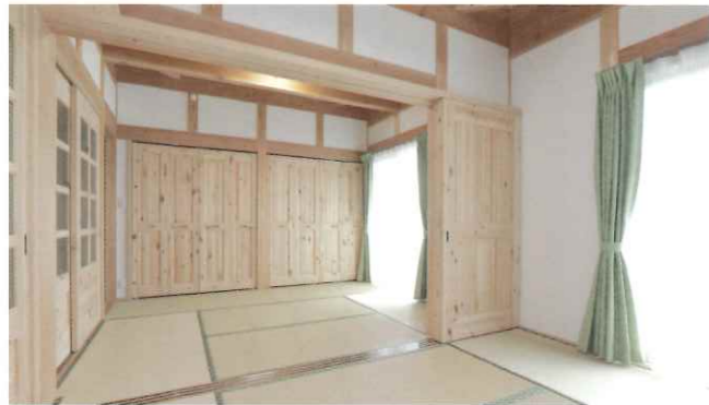
1階には真壁造りのすっきりした和室が2間。個室としても使えるように襖ではなく木の引き戸を採用
