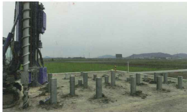
軟弱な地盤にはPCパイルによる地盤補強を実施。全ての杭(くい)を支持層まで到達していることを施工主と確認する
