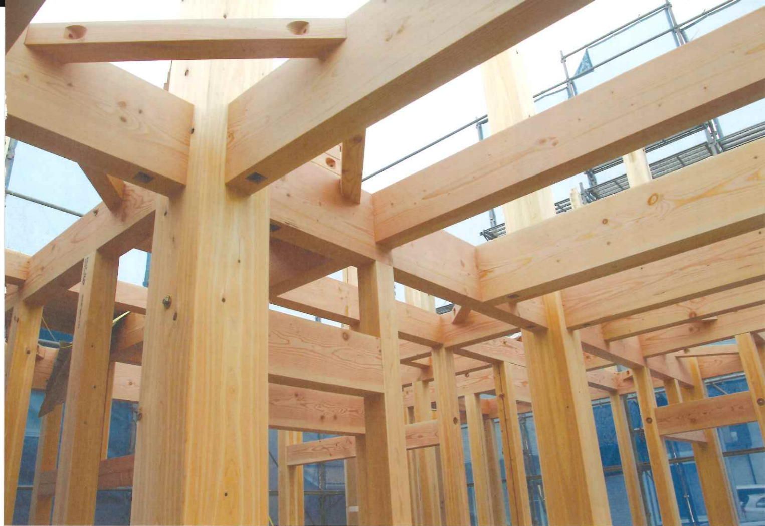
1尺角なら10年、8寸角なら7年自然乾燥させた粘り強いヒノキ材を使用。1本1本が圧倒的な強さを持つ柱や梁(はり)をしっかりと組み上げる。長期自然乾燥により、ヒノキの持つ免疫力が増し、薬剤は不要となるそう
