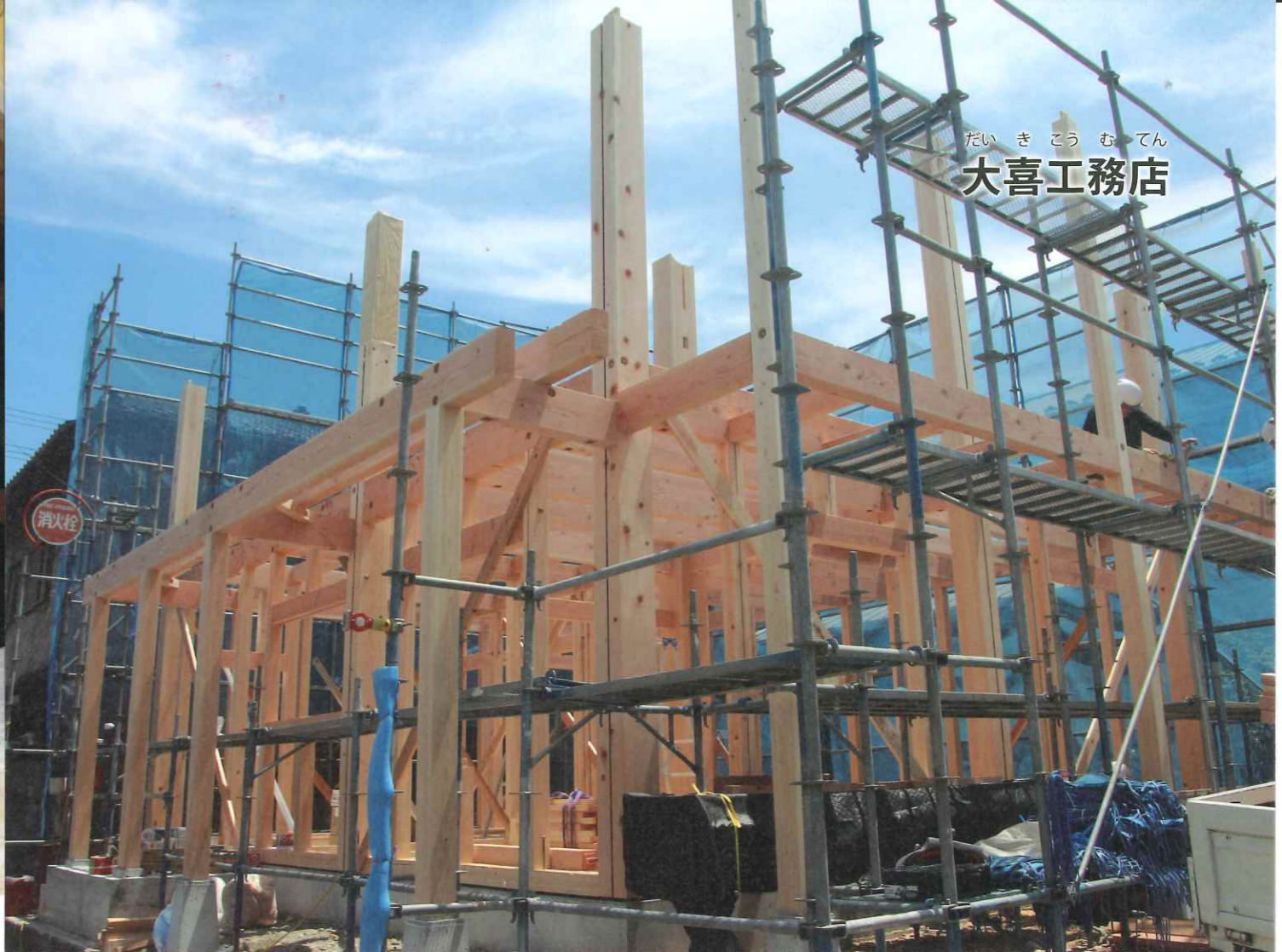
大黒柱は1尺2寸(36cm)角、周囲は9寸(27cm)角の長期自然乾燥させたヒノキを使用
