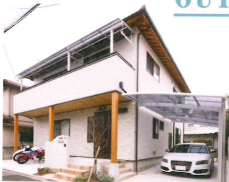
高度地区の高さ制限を考慮し、もともと採光が期待できなかった敷地の南側に寄せて最大限の建物を設計。外壁は質感にこだわり、1階正面のみ石膏貼りに仕上げている
