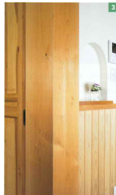
1階段は、熟練した大工の技による木組みを手ずりに用いて、美しく仕上げられています。1階側には節が少ない材を選び、玄関から見たときの印象に配慮しました。昇降がスムーズにできるように、幅1mのメーターモジュール設計にしています 2 2階のホールは、セカンドリビングなど多目的に使えるよう広めのスペースを確保しました。腰板を横張りにして、より広く見える工夫も施しています。「夏には、南北の窓を開けると気持ちのいい風が通ります」と妻 3 8寸角の檜を大黒柱として2本、通し柱も6本のうち4本に採用しました。檜は、良材の産地として名高い岐阜県東濃地方から仕入れ、長期自然乾燥して強度を高めて使用。「触り心地がよく、美しい見栄えが最高」と夫
