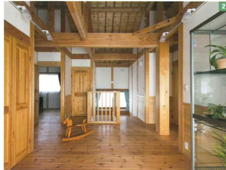
1階段は、熟練した大工の技による木組みを手ずりに用いて、美しく仕上げられています。1階側には節が少ない材を選び、玄関から見たときの印象に配慮しました。昇降がスムーズにできるように、幅1mのメーターモジュール設計にしています 2 2階のホールは、セカンドリビングなど多目的に使えるよう広めのスペースを確保しました。腰板を横張りにして、より広く見える工夫も施しています。「夏には、南北の窓を開けると気持ちのいい風が通ります」と妻 3 8寸角の檜を大黒柱として2本、通し柱も6本のうち4本に採用しました。檜は、良材の産地として名高い岐阜県東濃地方から仕入れ、長期自然乾燥して強度を高めて使用。「触り心地がよく、美しい見栄えが最高」と夫
